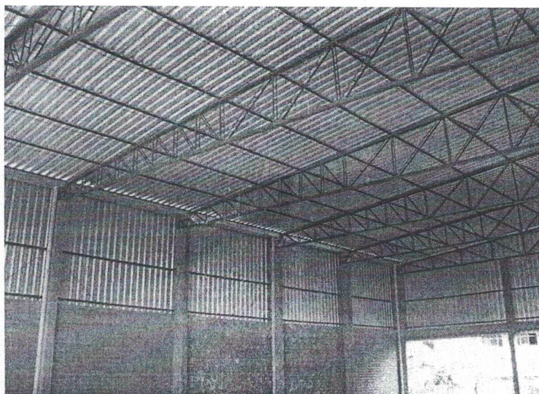
Figura 2 - EXEMPLO DE FECHAMENTO COM ALVENARIA E CHAPA METÁLICA
